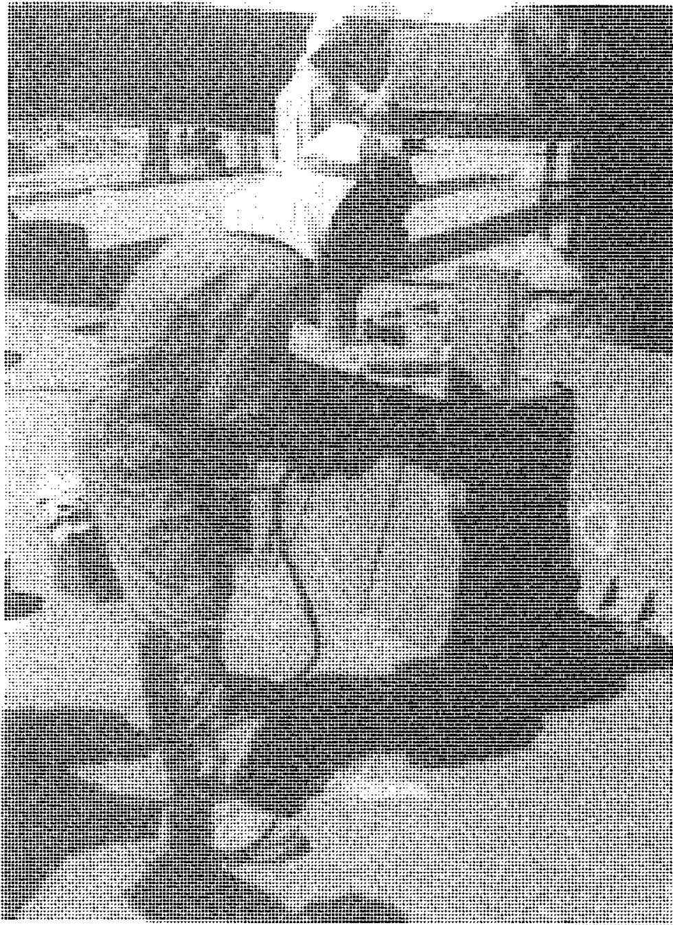
شکل ۸-۸ انجام جوش گوشت آزمایشی در وضعیت بریالا (۳ F).
